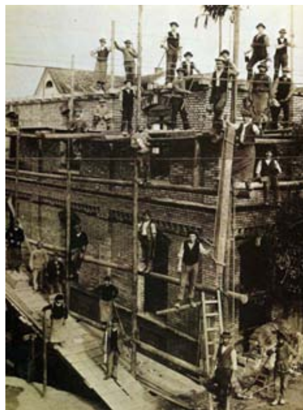
Anónimo, Construcción del Atelier Held, ca. 1895
